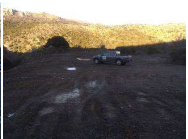
Αποκατεστημένος χώρος- πρώην ΧΑΔΑ στα Άνω Δολιανά από τον Δήμο Βόρειας Κυνουρίας
