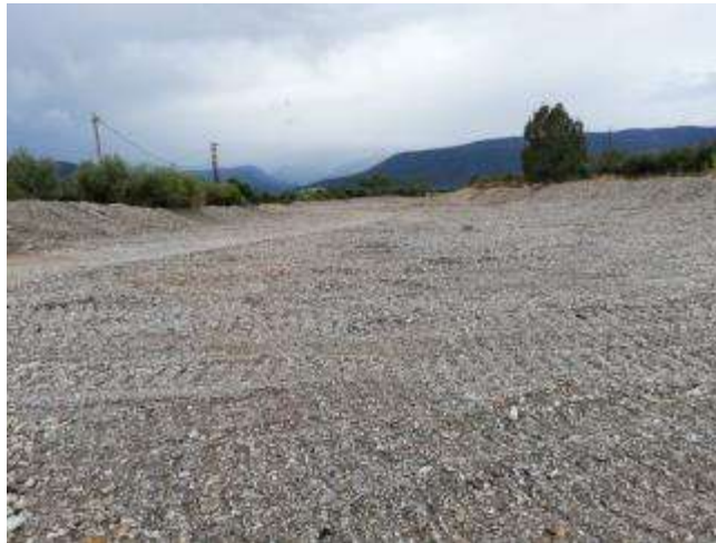
Διαμορφωμένη κοίτη του Ρέματος Βρασιάτη από την Περιφέρεια
